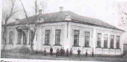
Старое здание школы.
